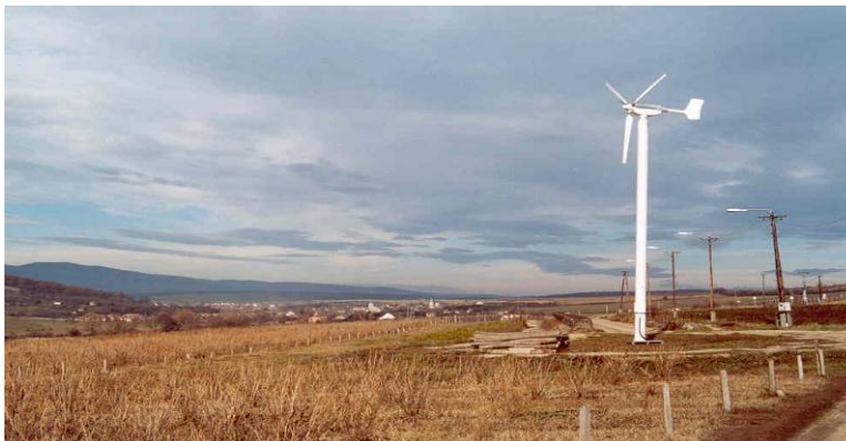
MAVIRKA fejlesztés I.: Az időjárásfüggően termelő 10 kW-os szélgenerátor
