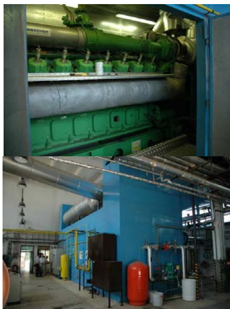
16 hengeres 1,6 MW-os gázmotor
