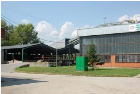
A Tatai Távhő Kft. berendezései
