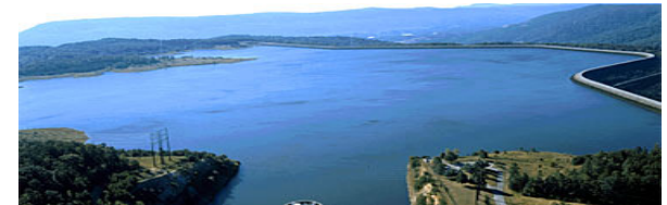
Szivattyús tározós vízerőmű
