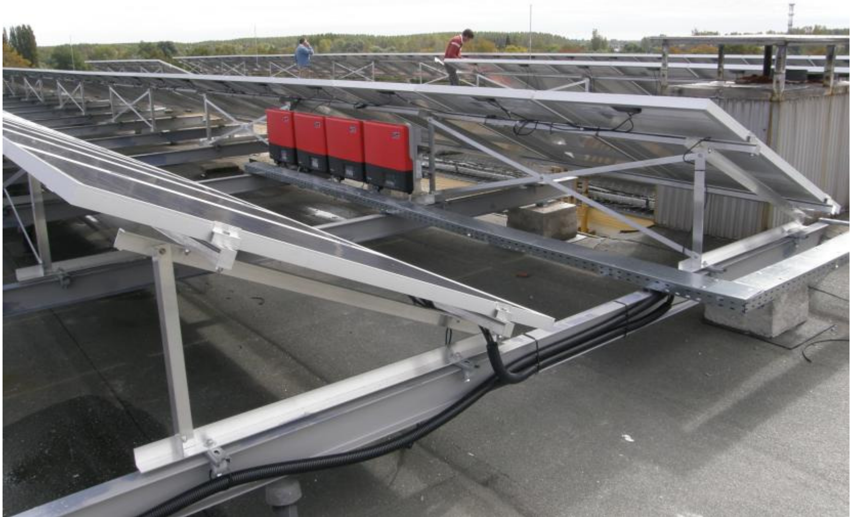
40 kWp rendszer telepítése a szolnoki önkormányzat tetején
