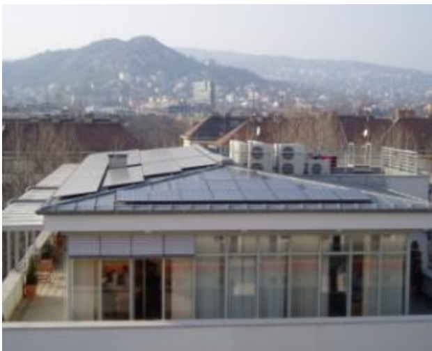
BUDAPEST, XI. KER. ÖNKORMÁNYZAT 20 kWp
