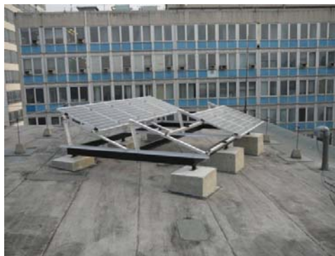
2. ábra: Kísérleti napelemes telep a VI épület tetején
