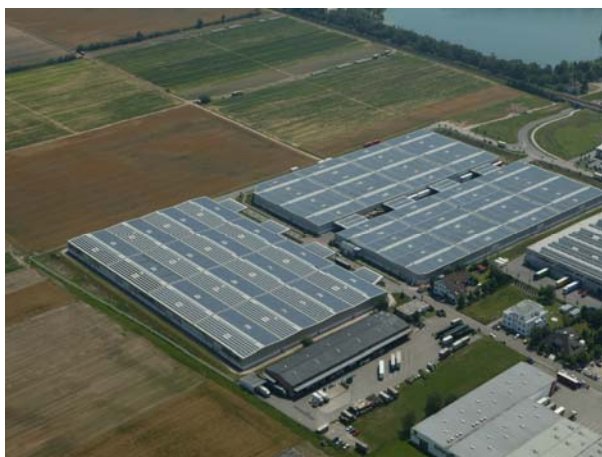
Hartmann AG; Németország 3,8 MWp
