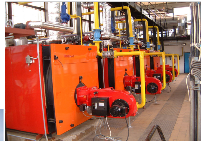
Távfüző művek felújítása, gázmotor beépítése
