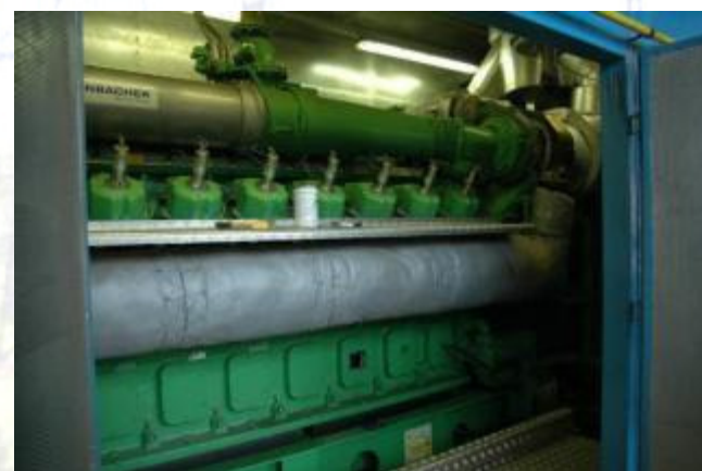
16 hengeres 1,6 MW-os gázmotor
